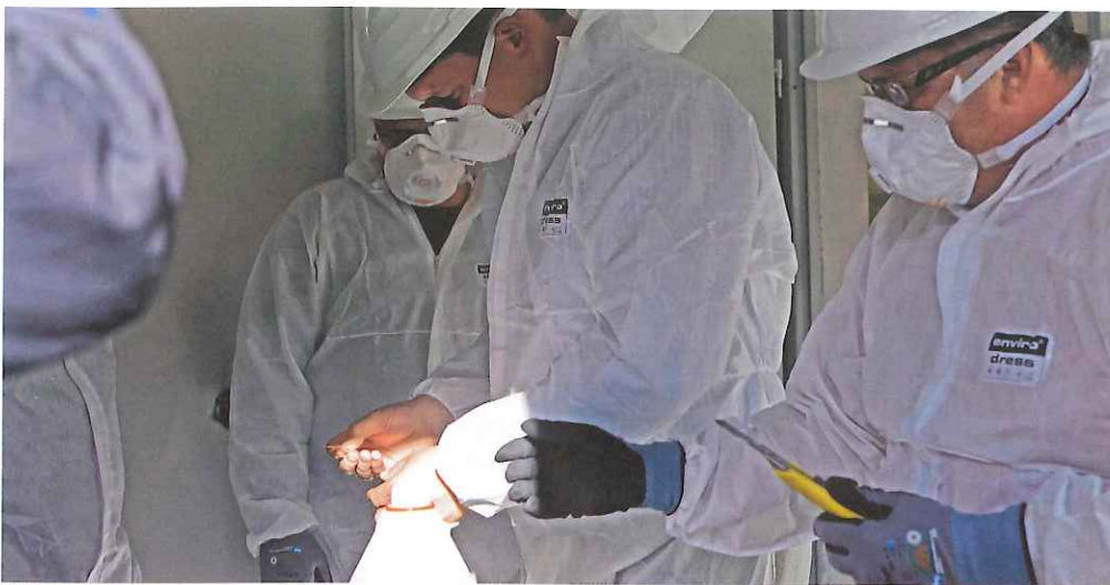
Sachverständige für Wasserschäden bei der Arbeit.
