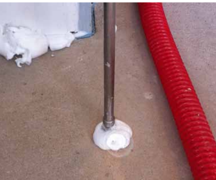
Injektion Biofilm zur Keimreduzierung im Bodenaufbau / Siehe Information Seite 14
