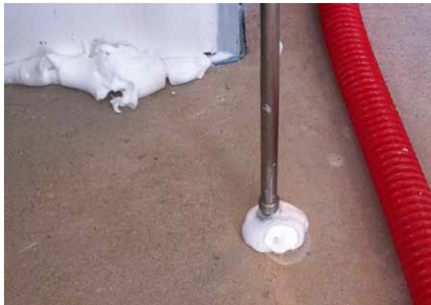
Abbildung: Injektion Trockenschaum zur Keimreduzierung im Bodenaufbau / schneller und kostengünstiger als Rückbau
